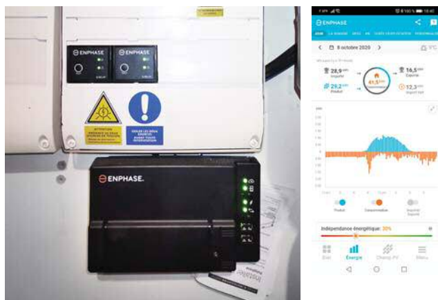
Le micro-onduleur et le système de monitoring et gestion d'énergie sont signés Enphase. Ce dernier délivre en instantané, sous forme de graphiques, des informations sur la consommation d'électricité et sur la production, panneau par panneau.
