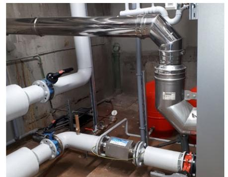
**Une installation similaire de l'anti-boues Edya Fluid' mise en place sur un circuit de chauffage.**
